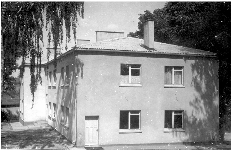
Wyremontowany budynek domu nauczyciela – 1967.
