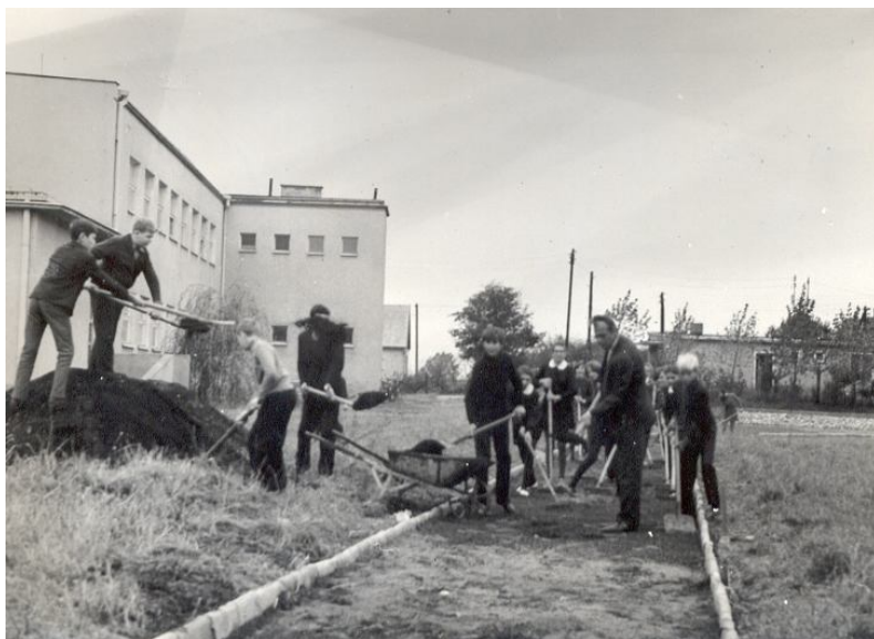
Młodzież z klasy VIII przy budowie bieżni – 1970 r.
